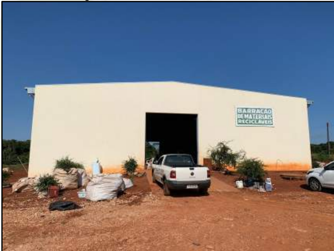
Figura 29 - Barracão de Materiais Recicláveis
