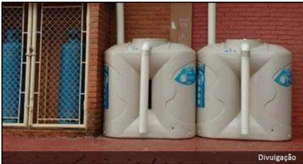
Figura 65 – Sistema de captação de água de chuva
