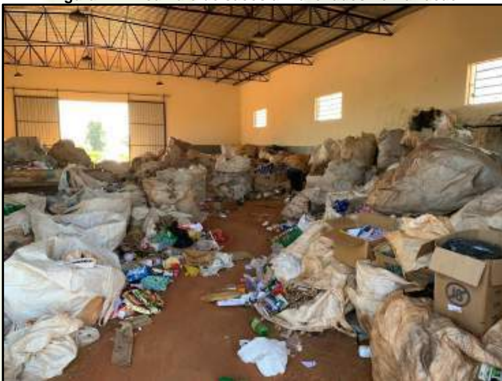
Figura 11 – Acúmulo de sacos armazenados no Barracão
