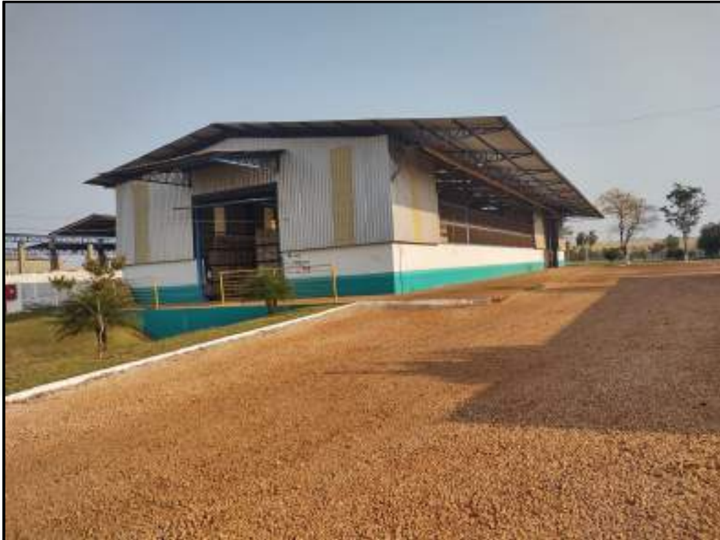
Figura 42 – Central de Recebimento ADIAESP de Taquarituba/SP
